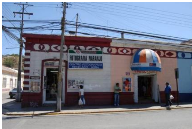
Foto N° 8-11: Continuidad de fachada.
