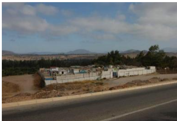
Foto N° 8-8: Cementerio ubicado al norte de la localidad
